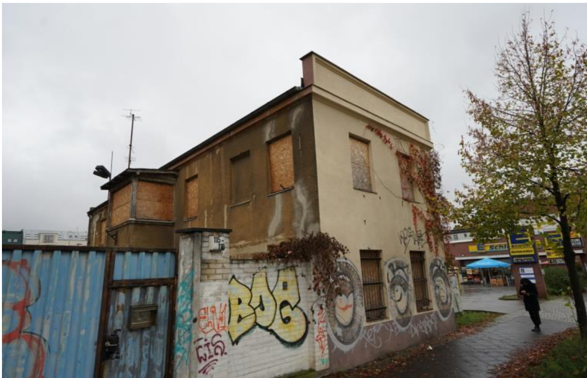
Abbildung 49: Leerstehendes Gebäude in der Pistoriusstraße mit hohem Instandsetzungs- und Modernisierungsbedarf
