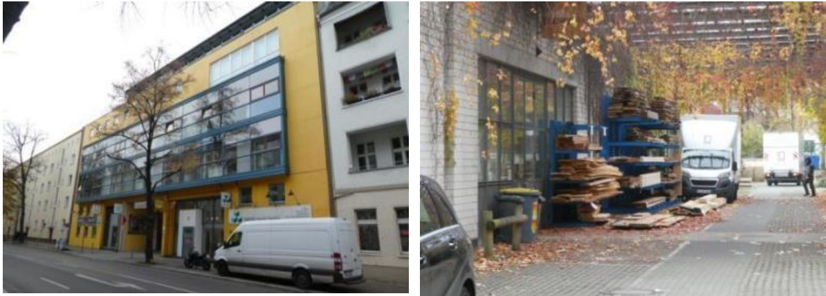
Abbildung 42: Das Nebeneinander von Wohnen und Gewerbe in der Roelckestraße 153 mit Lärmschutzvorrichtungen (Teilbereich 2, Block 135043)
