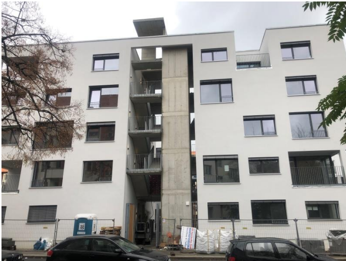
Abbildung 39: Wohnungsneubau am Pistoriusplatz
